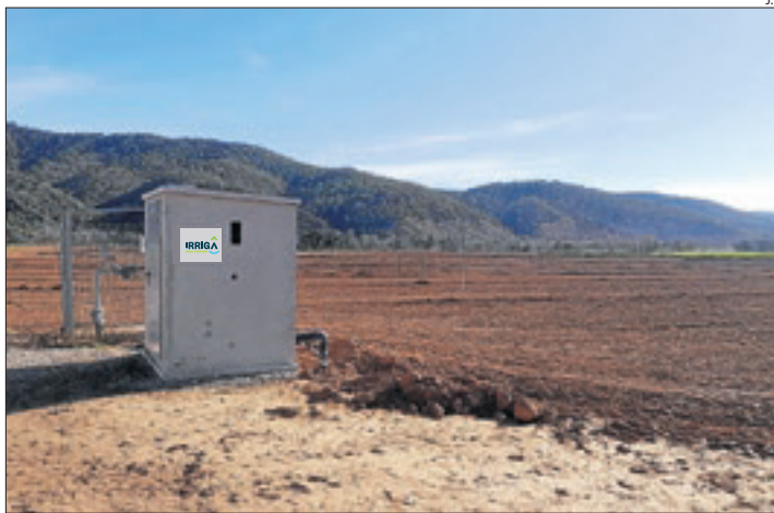
Una de les finques de Peramola amb la instal·lació del nou reg.
